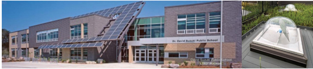
تصاویر ۴ و ۵- نمای کلی از مدرسه، جانمایی پنل های خورشیدی در نمای ساختمان مدرسه (سمت پایین)، نورگیرهای نصب شده در پشت‌بام (سمت بالا) ( https://www.hpbmagazine.org )
