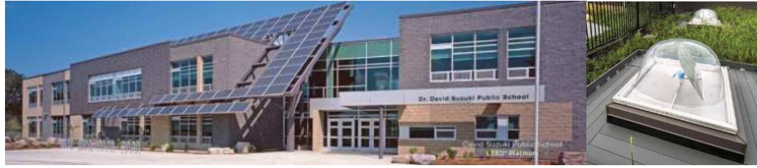
تصاویر ۴ و ۵- نمای کلی از مدرسه، جانمایی پنل های خورشیدی در نمای ساختمان مدرسه (سمت پایین)، نورگیرهای نصب شده در پشت بام (سمت بالا) (https://www.hpbmagazine.org)
