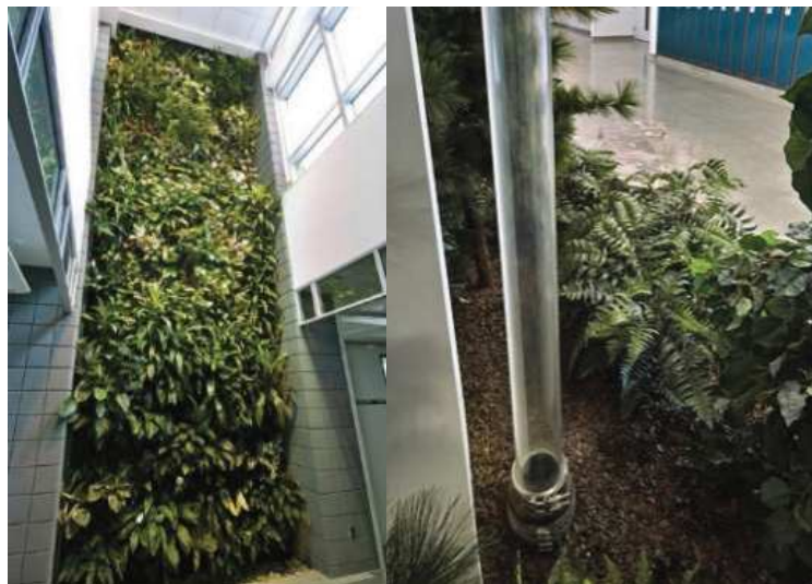
تصاویر ۷ و ۸- دیوار سبز (سمت راست)؛ لوله ی شفاف برای جمع آوری آب باران (سمت چپ) (https://www.hpbmagazine.org)
