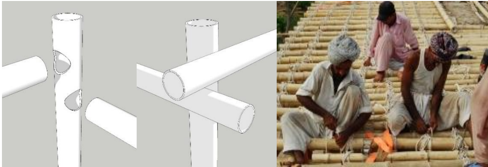
تصویر ۶- تصویر راست: سازه‌های کشویی و مهارهای کش بستی برای تثبیت آن‌ها؛ تصویر چپ: آماده کردن اتصالات برای بستن چوب‌های بامبو با طناب
